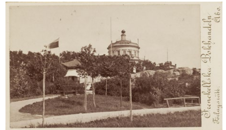
Turun Vartiavuoren puiston tähtitorni ja palotorni 1800- ja 1900-lukujen vaihteessa. Kuvassa näkyy tuoreeltaan istutettuja puita kallioiseen puistoon. Kuva: Rurik Hjelt, Turun museokeskus.
