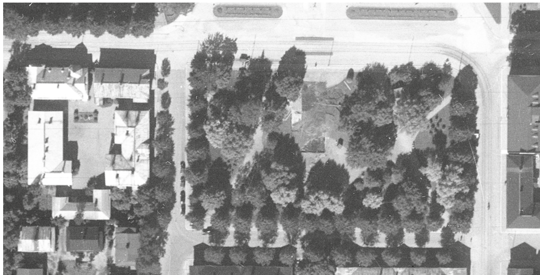
Ilmakuvassa vuodelta 1938 erottaa käynnissä olevan puiston uudistuksen. Keskeisestä nurmialueesta on aloitettu kaivamaan uutta suorakulmion muotoista keskiparterria. Kuvaaja: Havola. Sotamuseo/Puolustusvoimat.
