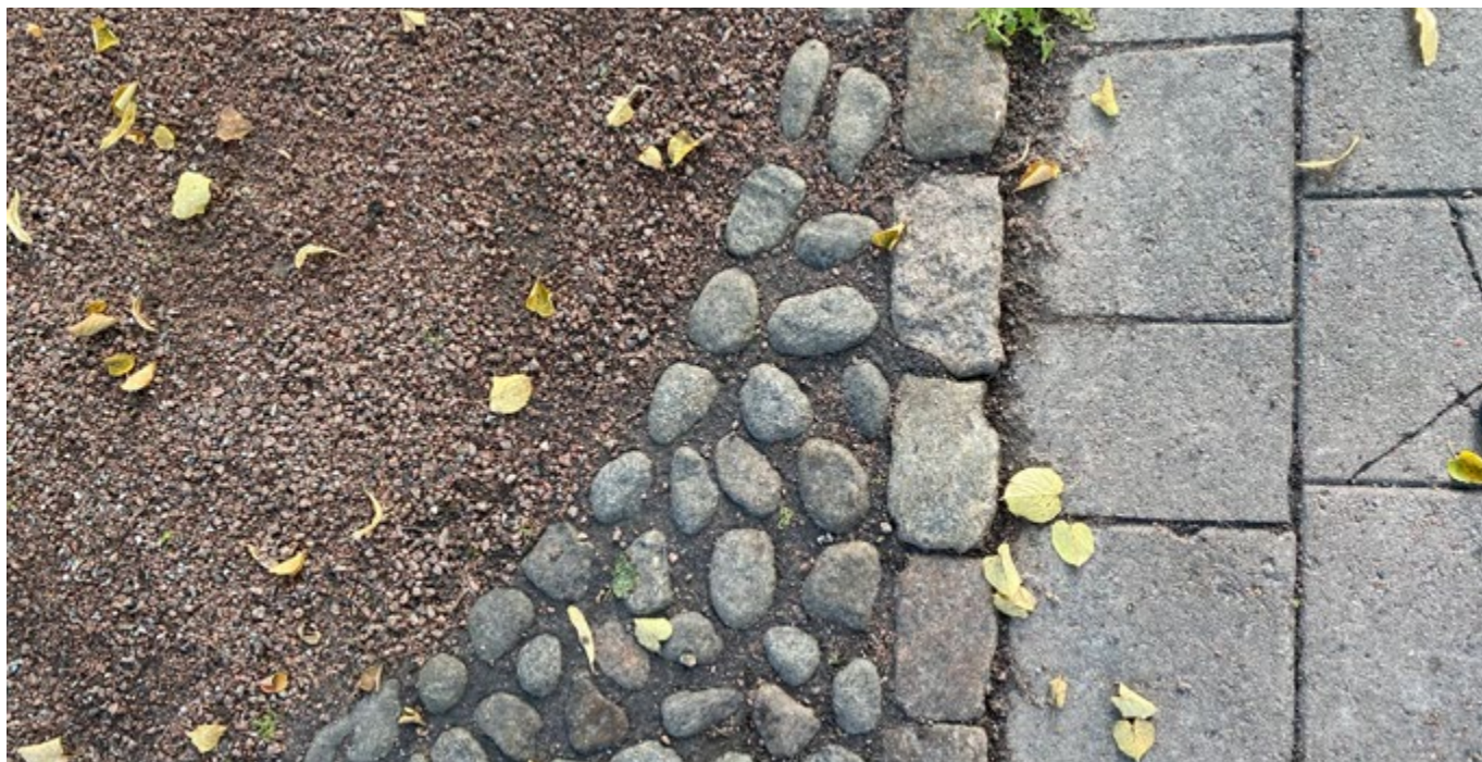
Puiston pinnoitteita ovat punainen kivituhka, mukulakiveys, graniittinupukivet reunakivenä sekä betoni-laatta jalkakäytävällä.
